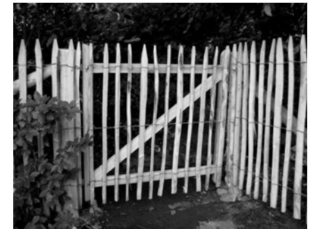
Torrahmen aus Lärchenholz mit befestigtem Zaunstück, Höhe 100 cm - 4 cm Zwischenraum
